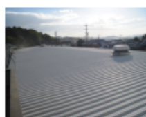
Fig.14 組立工場の屋根の遮熱塗装
