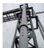
Fig.5 給水配管
