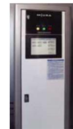
Fig.18 エアコンプレッサの台数制御装置
