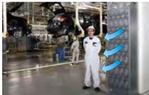
工場内の柱の低層部分に設置された空調吹き出し口
