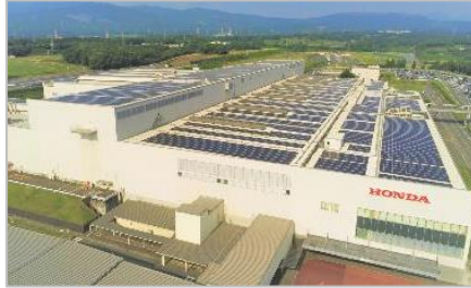
工場屋根ソーラー 3,400kW
