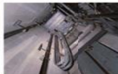
エレベーターケーブル
