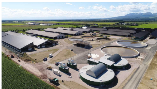
バイオガスプラント
