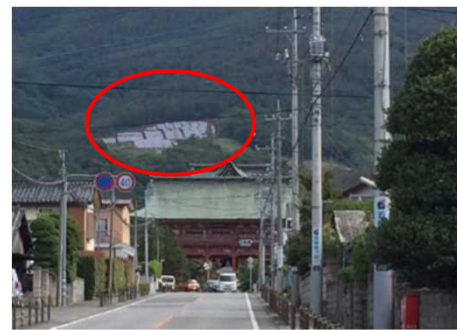
景観を乱すパネルの設置
