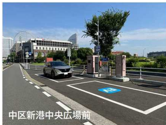
公道へのEV充電器設置
