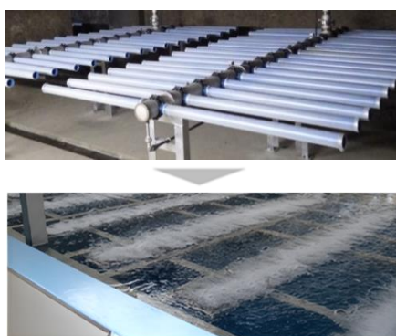
超微細散気装置（下水道）
