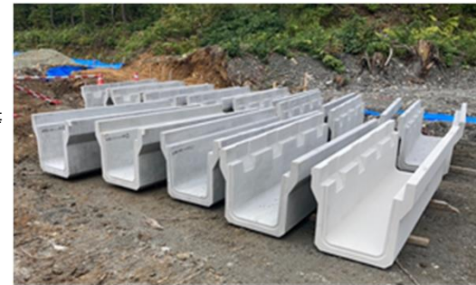
グリーンイノベーション基金を活用したCO2固定化コンクリート試行事例 (秋田県東成瀬村)
