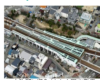
大物駅に導入された太陽光発電
