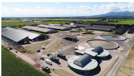
バイオガスプラント
