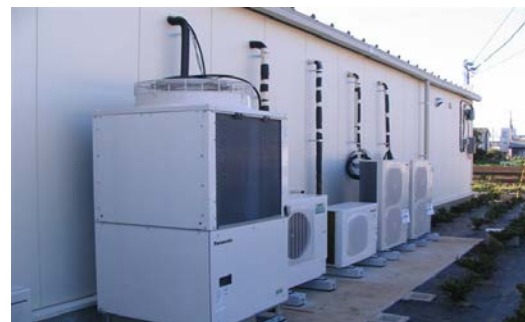
CO 2 冷媒の室外機
