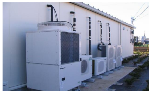
CO 2 冷媒の室外機
