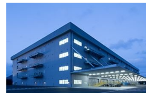
物流棟全体の照度を一元管理の例
