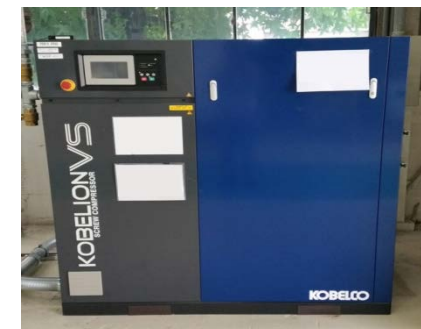
最新のコンプレッサー（高効率、見える化システム搭載）へ更新の例
