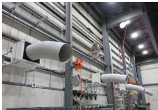
空調の高効率化（個別制御可能・ダクトレスのマルチキューブ採用）の例
