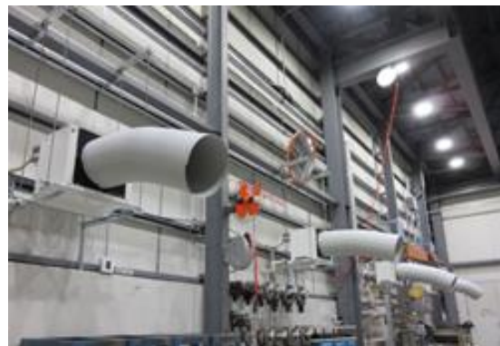
空調の高効率化の例 (個別制御可能・ダクトレスのマルチキューブ採用)
