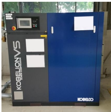
コンプレッサーの高効率化の例 (見える化システム搭載)
