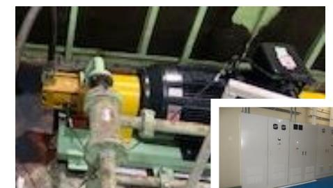
高効率油圧式モーターとINV制御の組合せ例
