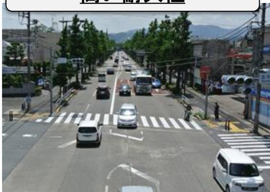
約50年間 大規模補修無しで供用している国道20号のコンクリート舗装区間(東京・八王子)
