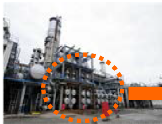
高効率熱交換器への入れ替え
