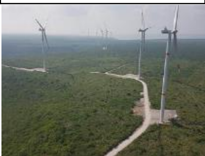
メキシコ トレスメサス【風力】 発電容量14.6万kW
