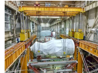
転用ガスタービンの吊り込み作業
