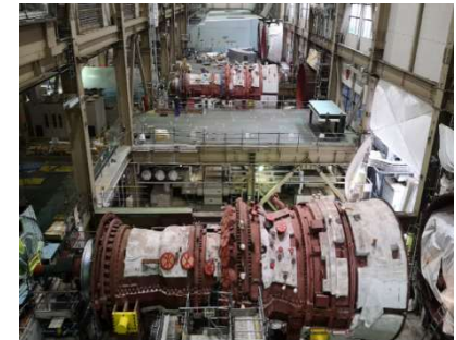
転用ガスタービンの設置状況
