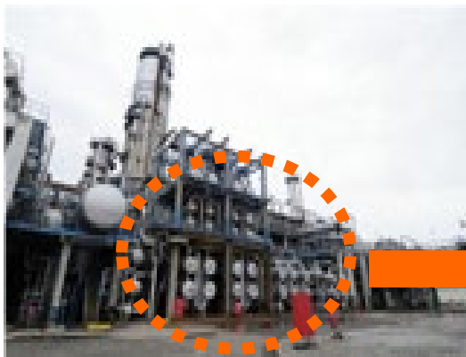
高効率熱交換器への入れ替え
