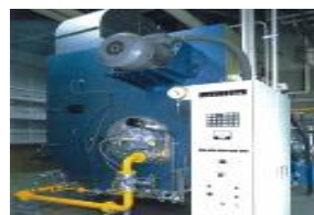
高効率蒸気ボイラー
