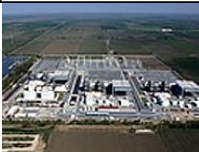
メキシコ MTファルコン【ガス火力】 発電容量223.3万kW
