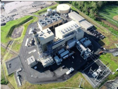
アメリカ バーズボロー【ガス火力】 発電容量48.8万kW
