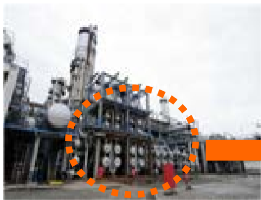
高効率熱交換器への入れ替え
