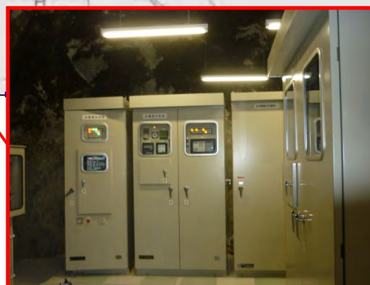
高圧配電盤・発電機制御盤
