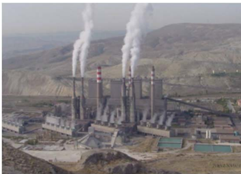
チャイラハン発電所
