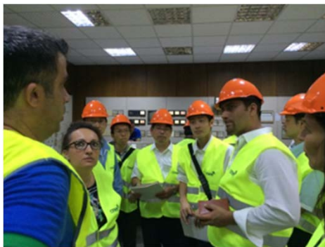
現場設備の状況確認
