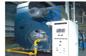
高効率蒸気ボイラー
