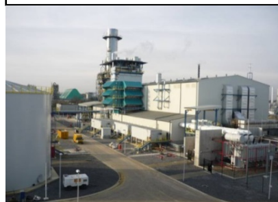
ベルギー T-Power 発電容量42.5万kW
