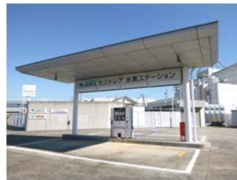
写真は既存のセントレア水素ステーション
