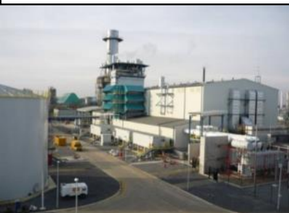
ベルギー T-Power【ガス火力】 発電容量42.5万kW
