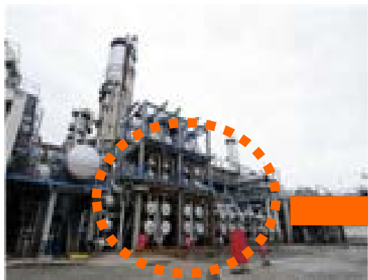
高効率熱交換器への入れ替え
