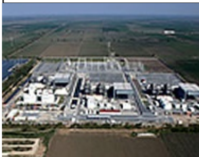
メキシコ MTファルコン【ガス火力】 発電容量220万kW
