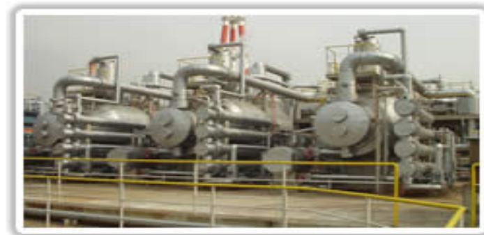
蒸気発生設備
