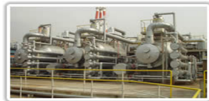
蒸気発生設備
