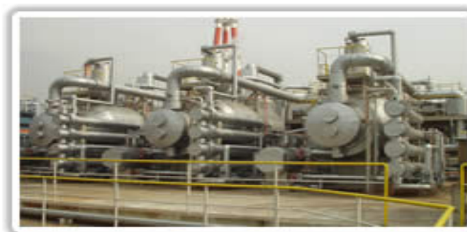
蒸気発生設備
