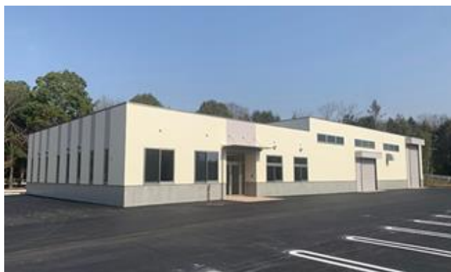
図. 水素大流量試験室
