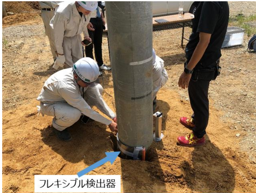
図. 欠陥が生じやすい地表付近の構造検査を可能にする 3 次元 X 線システム
