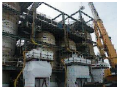
【上図】触媒交換の様子 （リアクター内へ触媒を運び込んでいるところ） 【右図】FCC（接触分解装置）のサイクロンセパレーターを更新の様子
