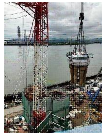
【上図】触媒交換の様子 （リアクター内へ触媒を運び込んでいるところ） 【右図】FCC（接触分解装置）のサイクロンセパレーターを更新の様子
