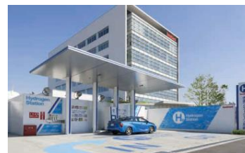
水素ステーション
