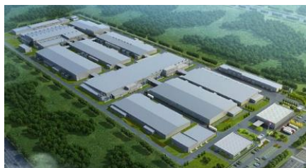
蓄電池製造工場
