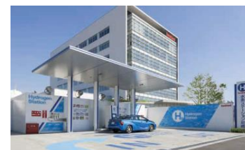
水素ステーション
