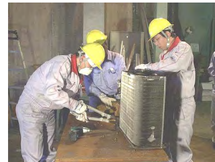
設計担当者による解体実習
