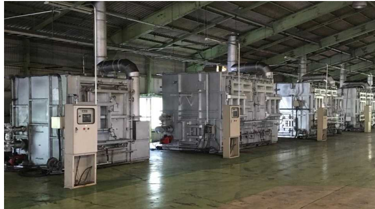
一次処理装置
