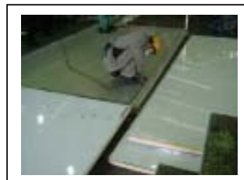
⑥ 床材の取外し
