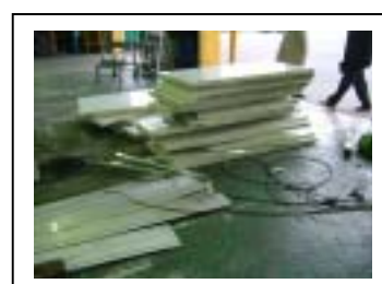
⑩ 断熱パネルの解体
