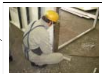
⑦-2 リヤドア枠の取外し
