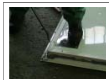
⑨-2 リヤドアの解体
