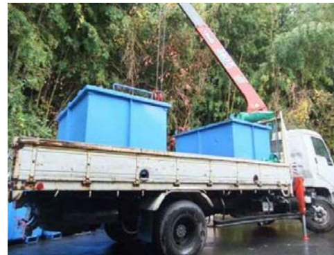
積込作業状況(上関町)
