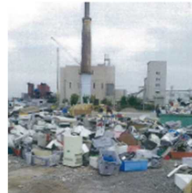
コンテナ設置前
