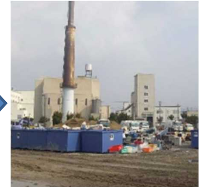
コンテナ設置後
