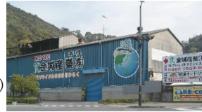
本社リサイクルセンター
