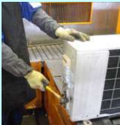
室外機カバーを外す
