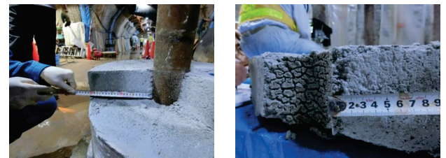
図11 幌延地下研究施設でのヒーターを用いた緩衝材ブロック熱影響評価試験の例 左：緩衝材ブロック内部の色調分布の変化 右：ヒーター接触部に認められた緩衝材のひび割れ
