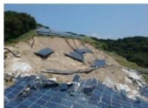
土砂崩れで生じた崩落
