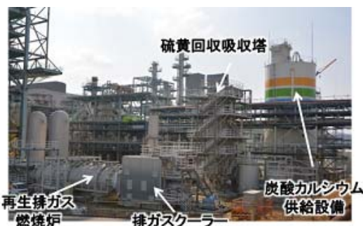
図 3-9 硫黄回収設備建設状況
