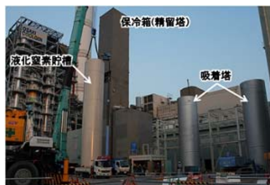
図 3-15 空気分離設備建設状況
