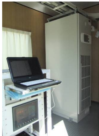
50kw級PCS(室内)
