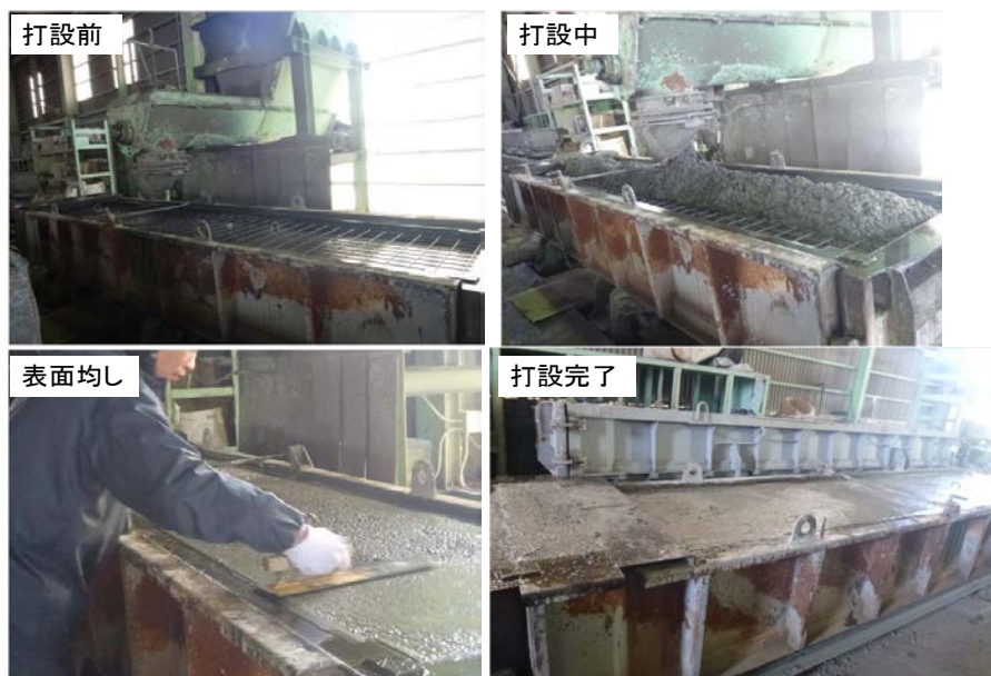
ロングベンチフリーム打設状況
